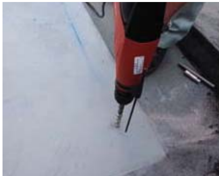
① 防水施工後、墨出し作業
