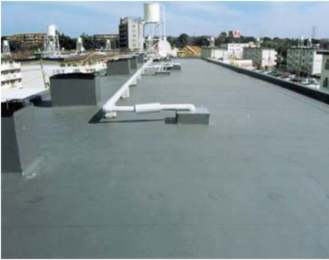
● 物件名/稲毛住宅団地(千葉県) ● 施工面積/10,000㎡
