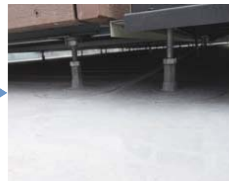
⑫ 部材接合箇所
