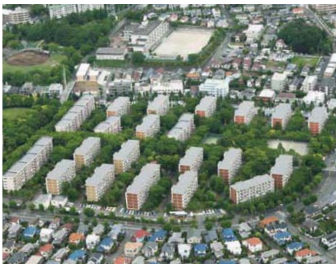
● 物件名/すすきの第二団地(神奈川県) ● 施工面積/10,000㎡
