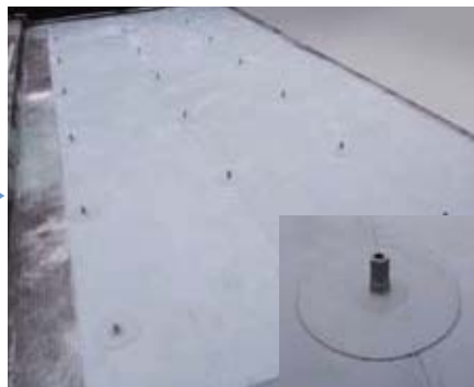
⑤ ベース金具・防水処理完成
