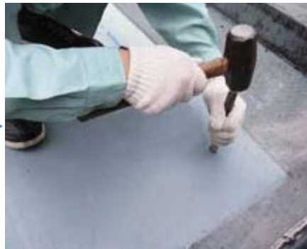
② 金属系アンカー打込み
