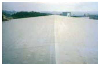
●施工完了時の防水層全景
