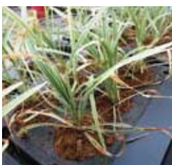
⑩ マジカルグリーン取付け 緑化ポット設置
