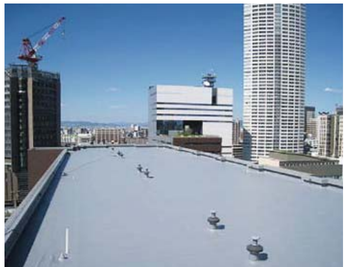
● 物件名/ルイシャトレ中之島(大阪府) ● 施工面積/800㎡
