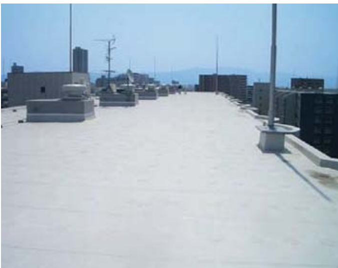
● 物件名/淀川パークハウス(大阪府) ● 施工面積/10,000㎡
