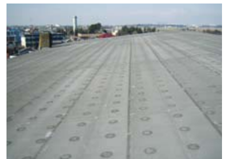
●20年経過時の防水層状況
