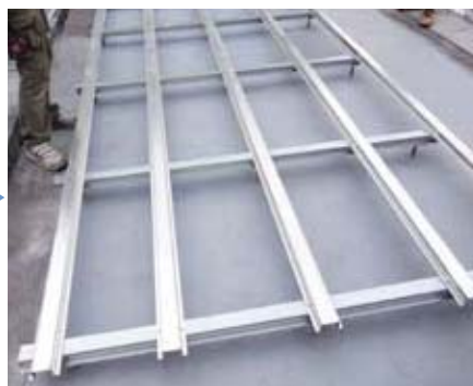
⑧ 大引・根太 取付け
