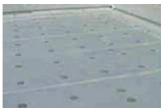
▲IHディスク鋼板の取付け
