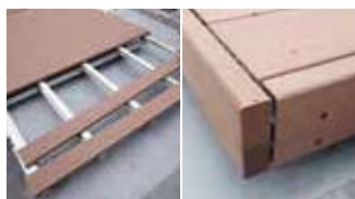
⑨ ウッドデッキ敷設・固定
