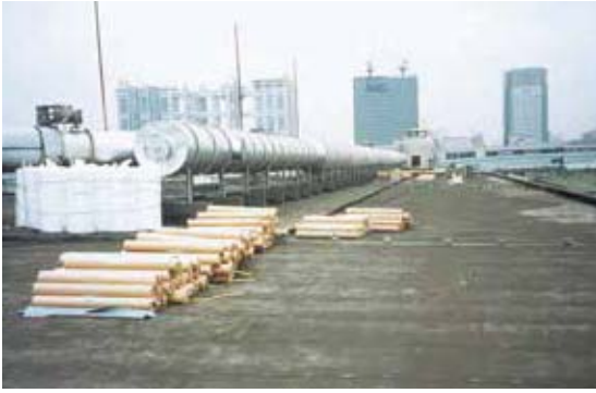
施工準備<サンタックIB材料荷姿> ●サンタックIBシート ●IB積層鋼板 ●副資材
