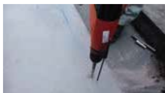
① 防水施工後、墨出し作業
