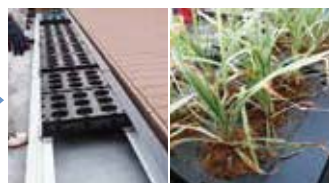
⑩ マジカルグリーン取付け 緑化ポット設置
