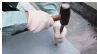
② 金属系アンカー打込み
