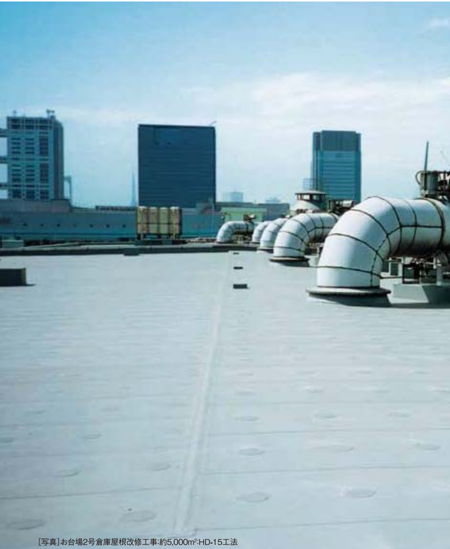
[写真]お台場2号倉庫屋根改修工事:約5,000m 2 :HD-15工法
