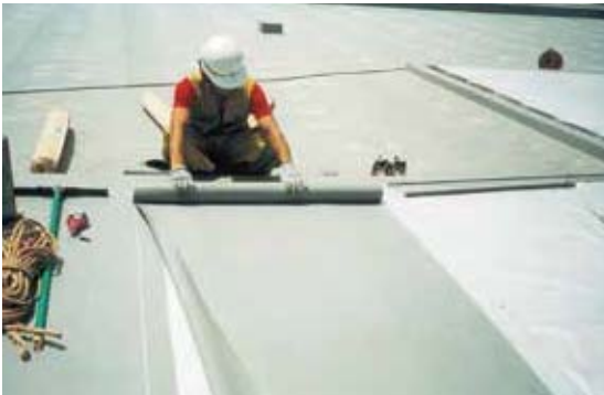
IBシート張付け ●IBシートを割付け、平場のディスク鋼板に溶着する。 ●IBシートの引張り率は、最大0.2%未満としてください。過度の引張りは、性能に影響します。(外気温等により初期にシワが発生する事があります。)
