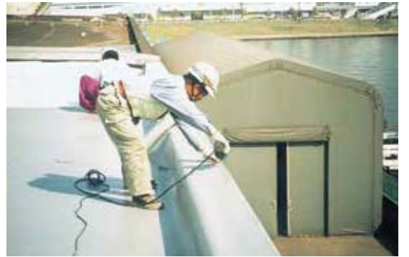
立上りシートの張付け ●端末部鋼板 #21
