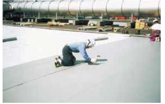
IBシートの接合 ●溶剤溶着(IB溶着剤) ●熱風融着(熱風機)
