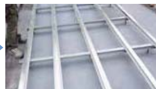
⑧ 大引・根太 取付け
