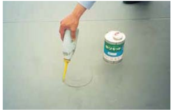
IBリキッド塗布 ●IBシートジョイント部全線に塗布
