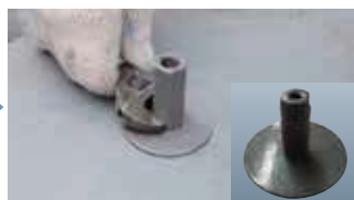
③ ベース金具 取付け
