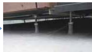
⑫ 部材接合箇所
