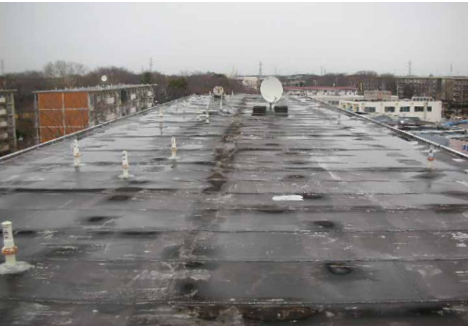
トップコートが無くなった防水例 紫外線からの防御がなくなり防水層自体の劣化が進む
