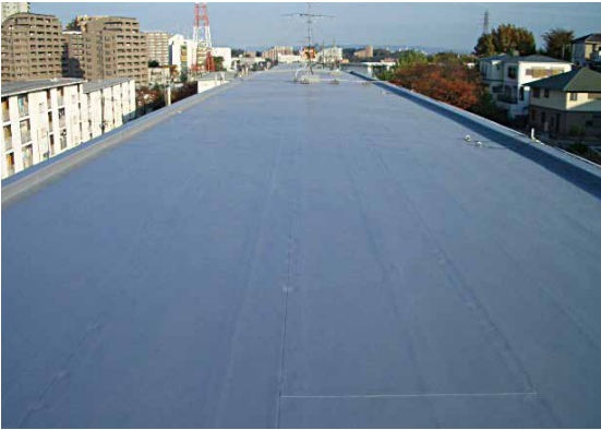
トップコートが無くなった防水例 紫外線からの防御がなくなり防水層自体の劣化が進む
