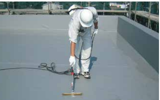
探傷試験作業
