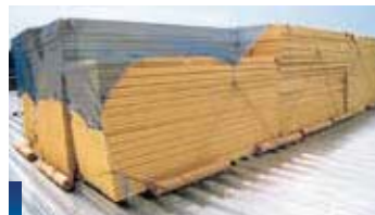
硬質ウレタンフォーム(イソシアヌレートボード)断熱材の荷揚げ納入・養生事例
