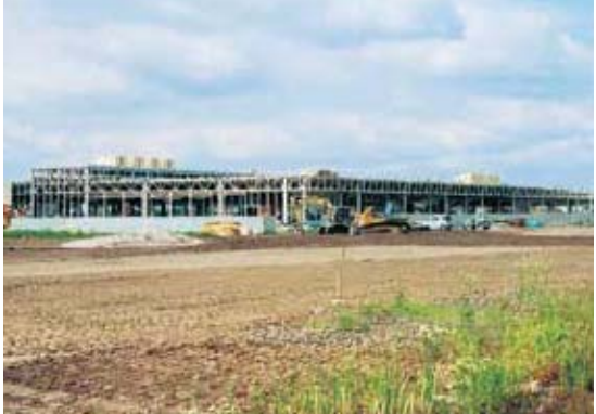
① スーパーセンター建物鉄骨外観
