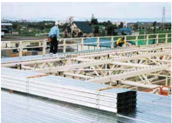
③ アイルーフ75敷き込み状況②
