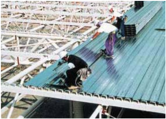
② アイルーフ75敷き込み状況①
