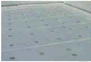
▲IHディスク鋼板の取付け
