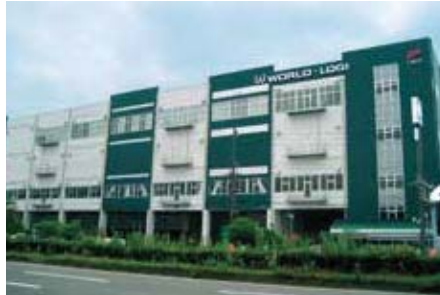
南港物流配送センター ●約11,000㎡
