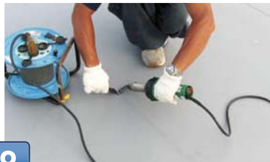
8 立上りIBシート張付け
