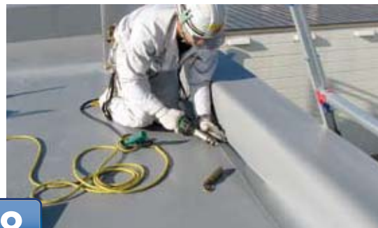
7 平場のIBシート張付け
