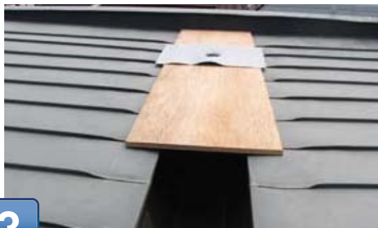
2 断熱材敷込み状況
