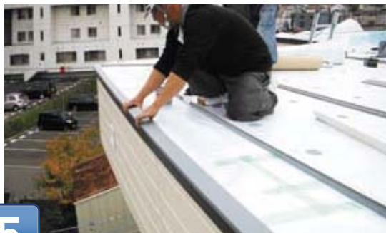
4 緩衝材及びIBディスク鋼板止付け
