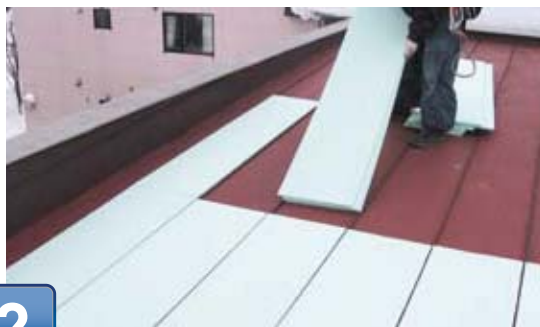
1 既存屋根下地の確認
