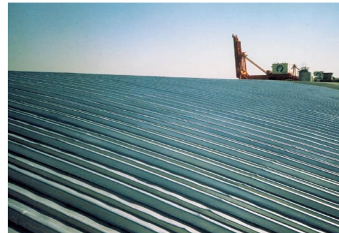
お台場ライナー埠頭1号倉庫(E号折版屋根) (東京都) 12,000㎡
