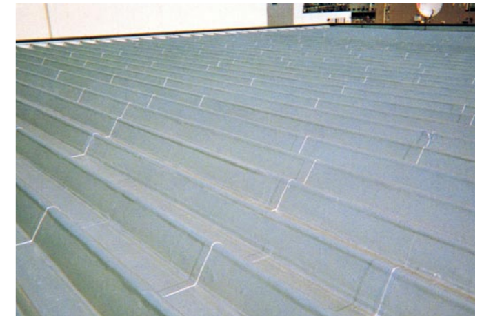
パーカーハネフィン日本(丸はぜ折版屋根) (神奈川県) 1,600㎡
