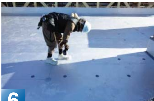
5 断熱材敷き込み
