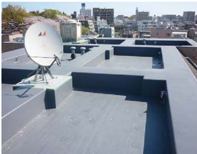
●物件名/レガロ南浦和(埼玉県) ●施工面積/500㎡
