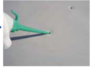
4 下地塩ビにEP-10注入
