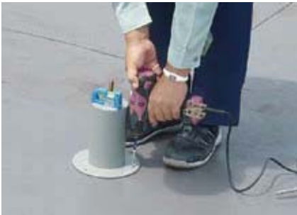
5 ソーラー基礎 H-185取付け
