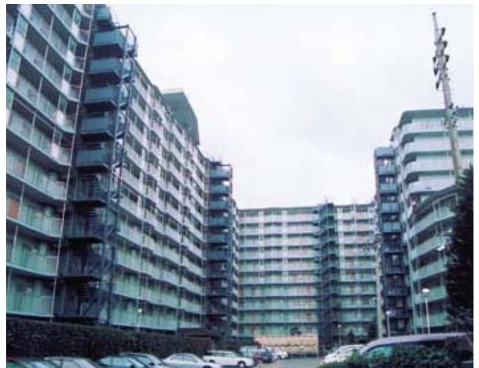
●物件名/戸田第一スカイハイツ(埼玉県) ●施工面積/6,400㎡
