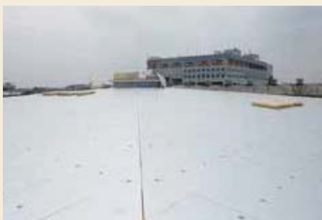
4 断熱材敷き込み 寄棟を中心に合わせて敷き込み
