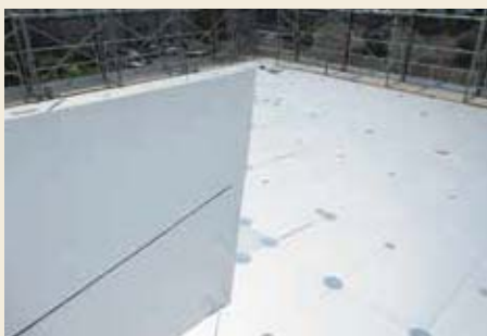
5 ディスク鋼板・IB積層鋼板の取付け
