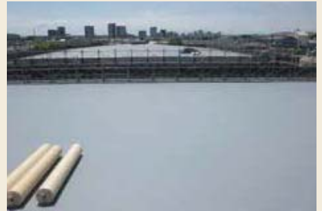
6 IB-HWCシート敷き込み・張り付け完了
