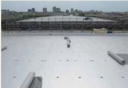
5 ディスク鋼板・IB積層鋼板(出入隅・端末)の取付け
