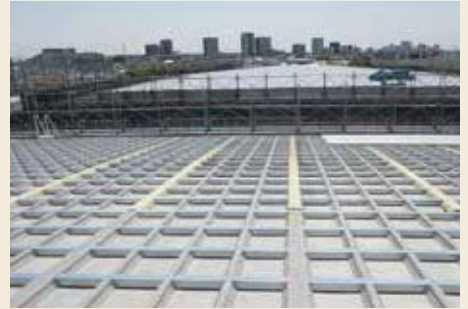
3 RS下地金具取付け状況 全景 (ディスク鋼板取付け箇所)に配置
