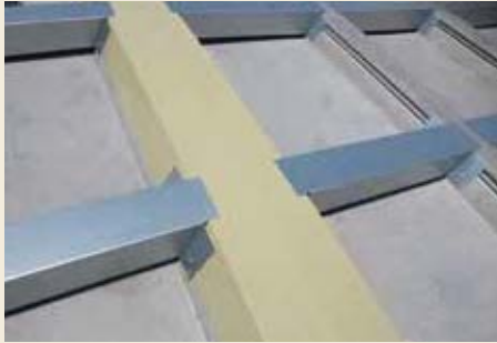
2 折板屋根用RS下地金具取付け状況
