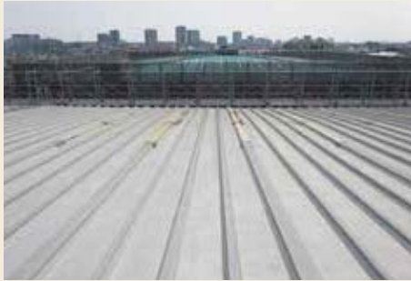
1 既存折板屋根全景 折板幅500mm
