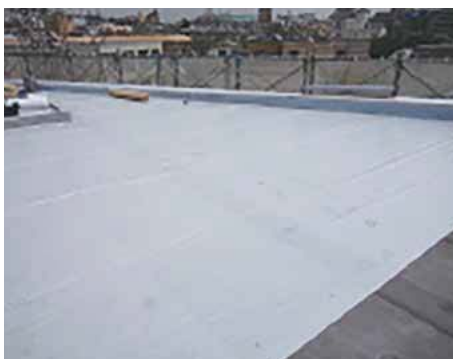
既存防水シートの上に緩衝フォーム敷き込み
