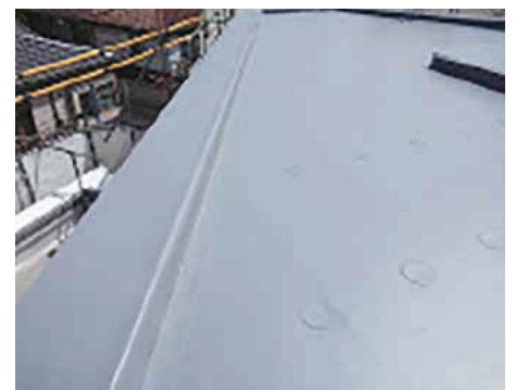
IB-HWCシートの敷き込み・張り付け完了
