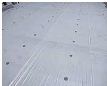
ディスク鋼板の固定 (既存のディスク鋼板位置と重ならない様に固定)
