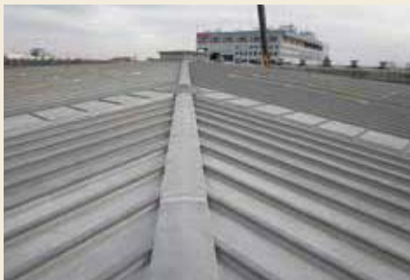
1 既存折板屋根 寄棟部
