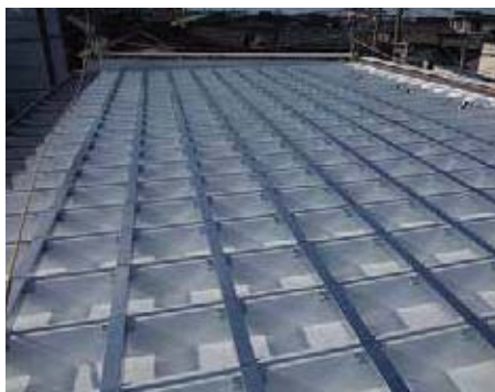
RS下地金具取付け状況(専用ビスで4箇所固定)
