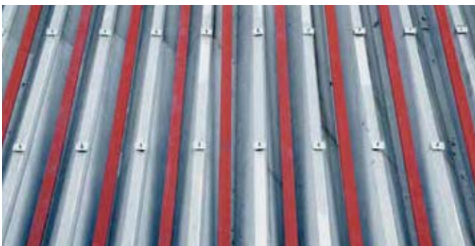
C型鋼アンクル 配置前状況
