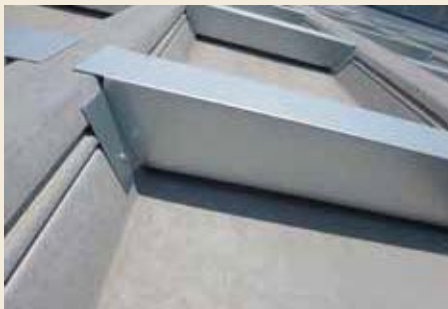
2 RS下地金具取付け状況 (専用ビスで4箇所固定)
