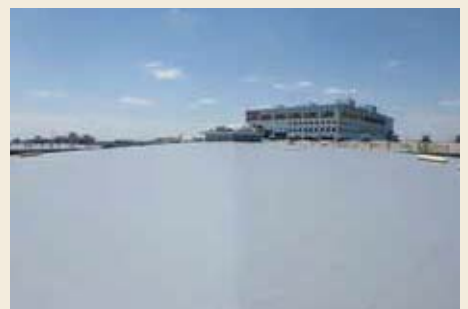
6 IB-HWCシート敷き込み・張り付け完了 (寄棟部は増し張り)
