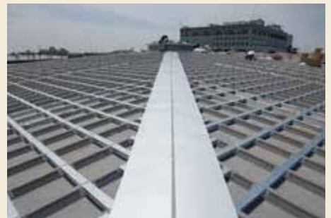
3 寄棟部の板金補強
