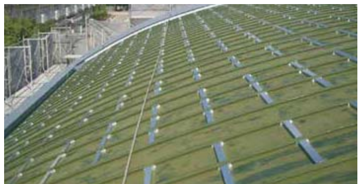
RS下地金具取付け状況(ディスク鋼板取付け箇所)に配置)
