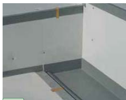
7 積層鋼板突合せ部の状況 5mm程度隙間をあけ、目地テープ50mm幅を貼付ける。
