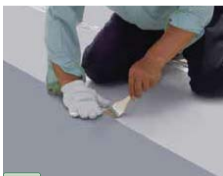
6 床面シート張り
