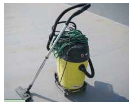
5 NBCボードの清掃 掃除機(業務用等)による清掃を行い、NBCボードとIBシートの間への異物等の混入を防止する。
