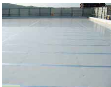
3 防水下地完成
