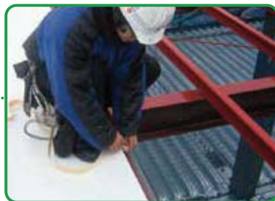
耐火フェルト貼付け NBCボード短辺部には専用耐火フェルトを貼付け、ボードで圧縮介在させる。 厚さ5mm×幅35mm×20m巻 材質：耐火フェルト
