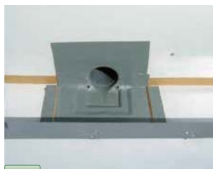
4 Dドレン取付け 新築用塩ビディッピングドレンの取付け。 側溝部出隅に#11鋼板取付け。 平場と立上りの入隅部は、絶縁用クラフトテープを貼付ける。
