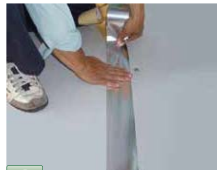
2 NBCボードジョイント部 アルミテープ貼り 長手・幅方向共
