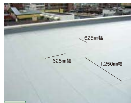
11 完成 風圧力が高い場合は、ハーフシート(625mm幅)を使用する場合があります。
