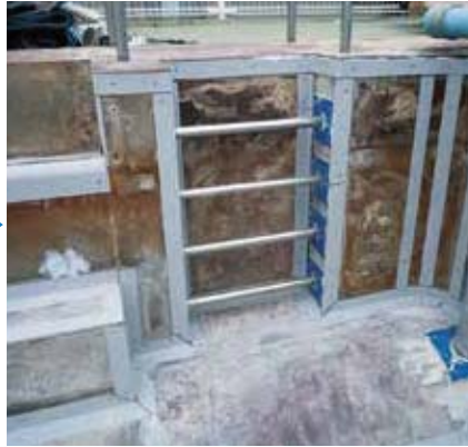
2 IB積層鋼板取付け
