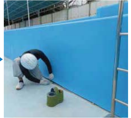
3 側壁面シート張込み
