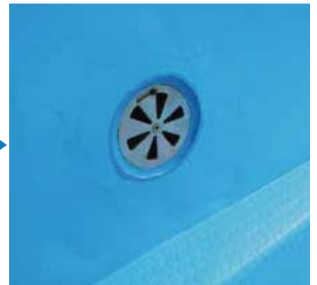
6 IBエポロック EP-30塗布 IBエポコートを必ず上塗りする。
