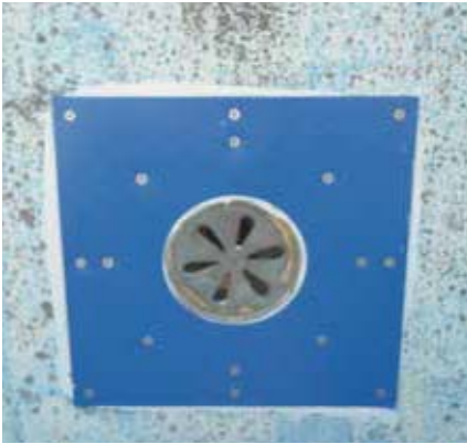
1 循環口まわり硬質塩ビ板取付け (IBエポロックEP-30裏打ち)
