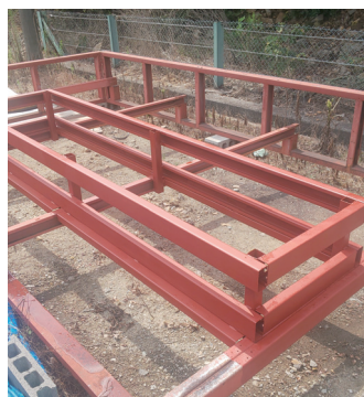
ひかり屋根設置架台作成
