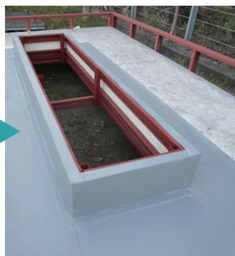
サンタック IB シート施工
