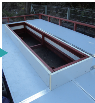
NBC ボード施工
